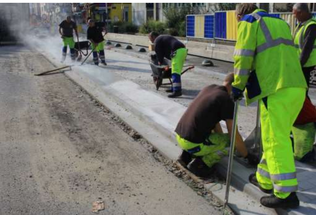
Брюссель, Гент. Технология «тиснения» по горячему. GAMA ASPHALT S.A.
