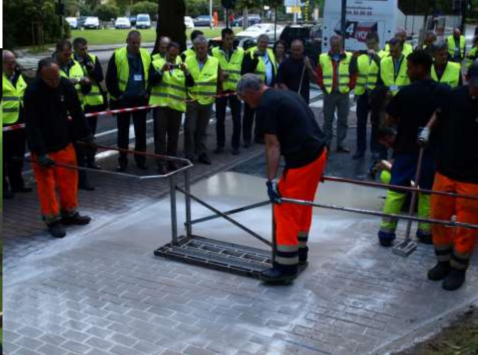
Брюссель, Гент. Технология «тиснения» по горячему. GAMA ASPHALT S.A.
