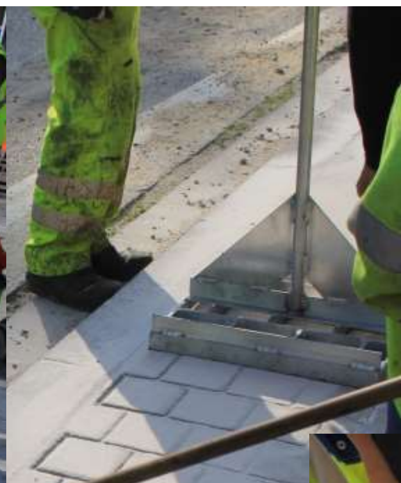
Брюссель, Гент. Технология «тиснения» по горячему. GAMA ASPHALT S.A.
