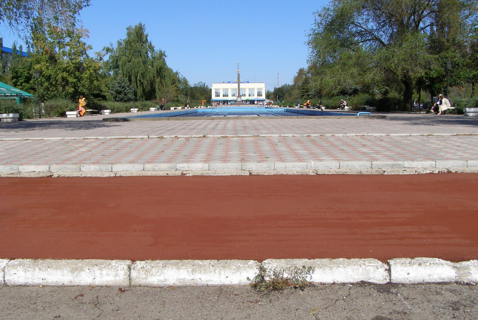
Покрытие из холодного цветного асфальтобетона г. Северодонецк, 2012 г.
