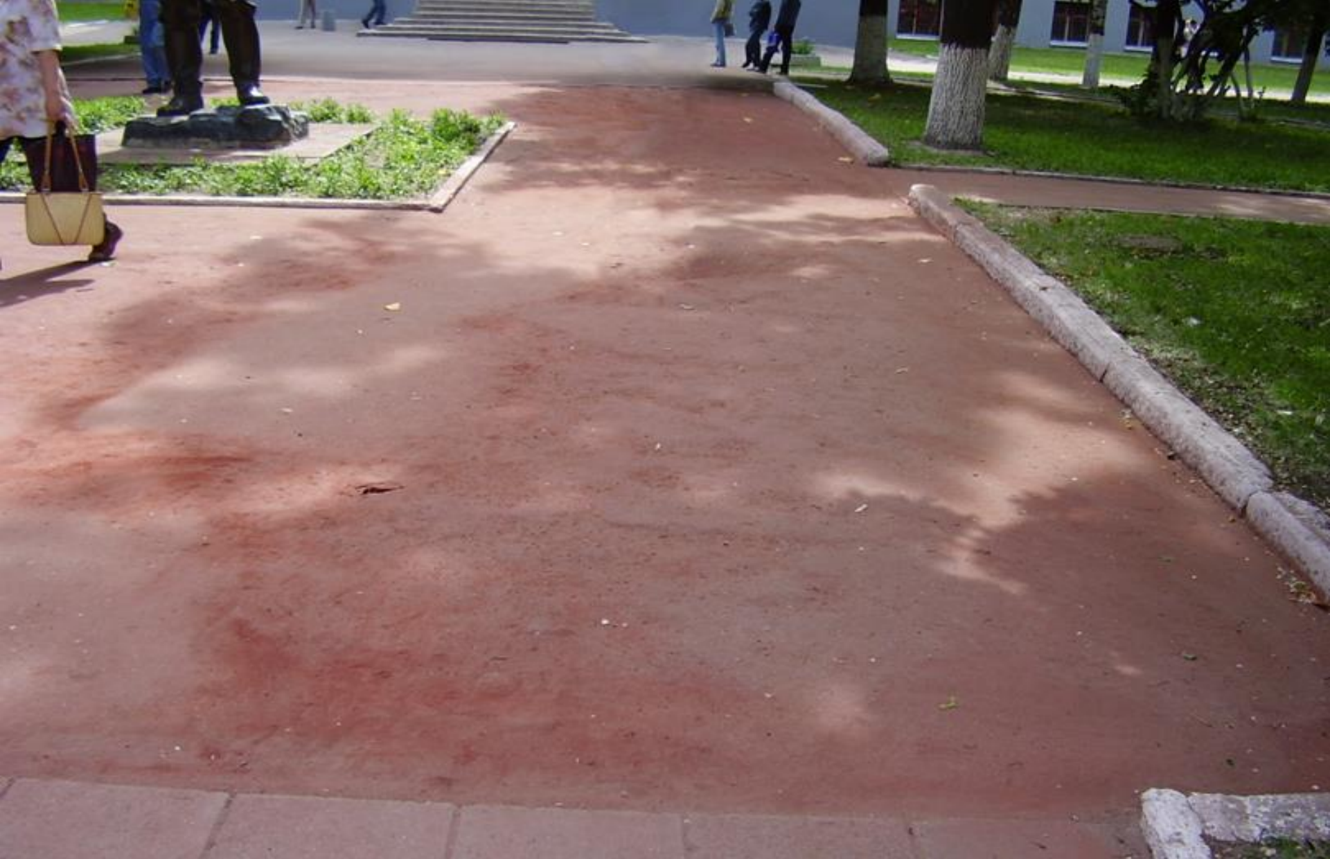
Площадка из цветного асфальтопекобетона в г.Харькове (1986 г.) возле памятника Артема - разрушилась через 2 года
