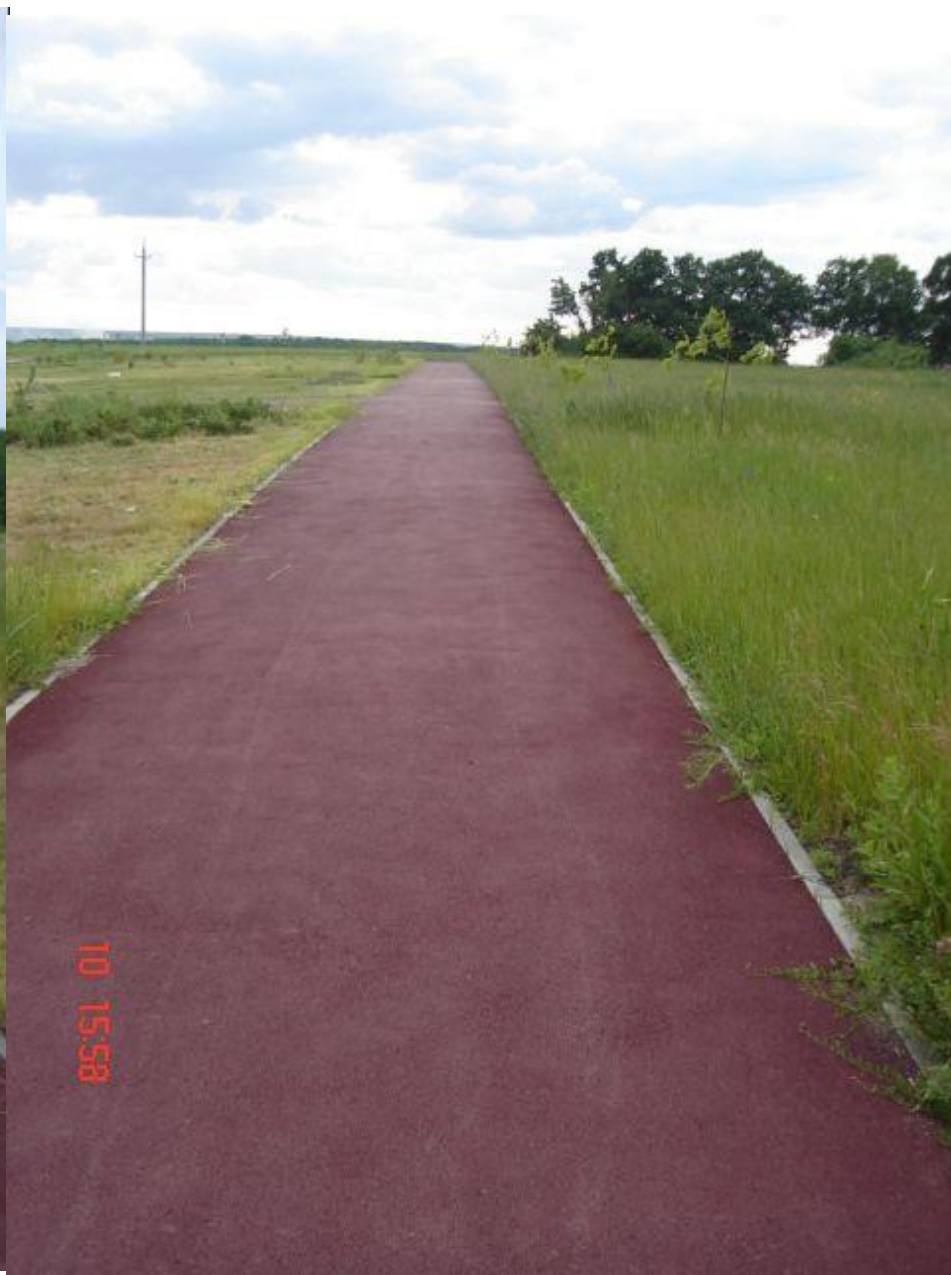
Покрытие из цветного асфальтобетона, устроенное у Национального мемориального комплекса «Высота маршала И.С.Конева»
