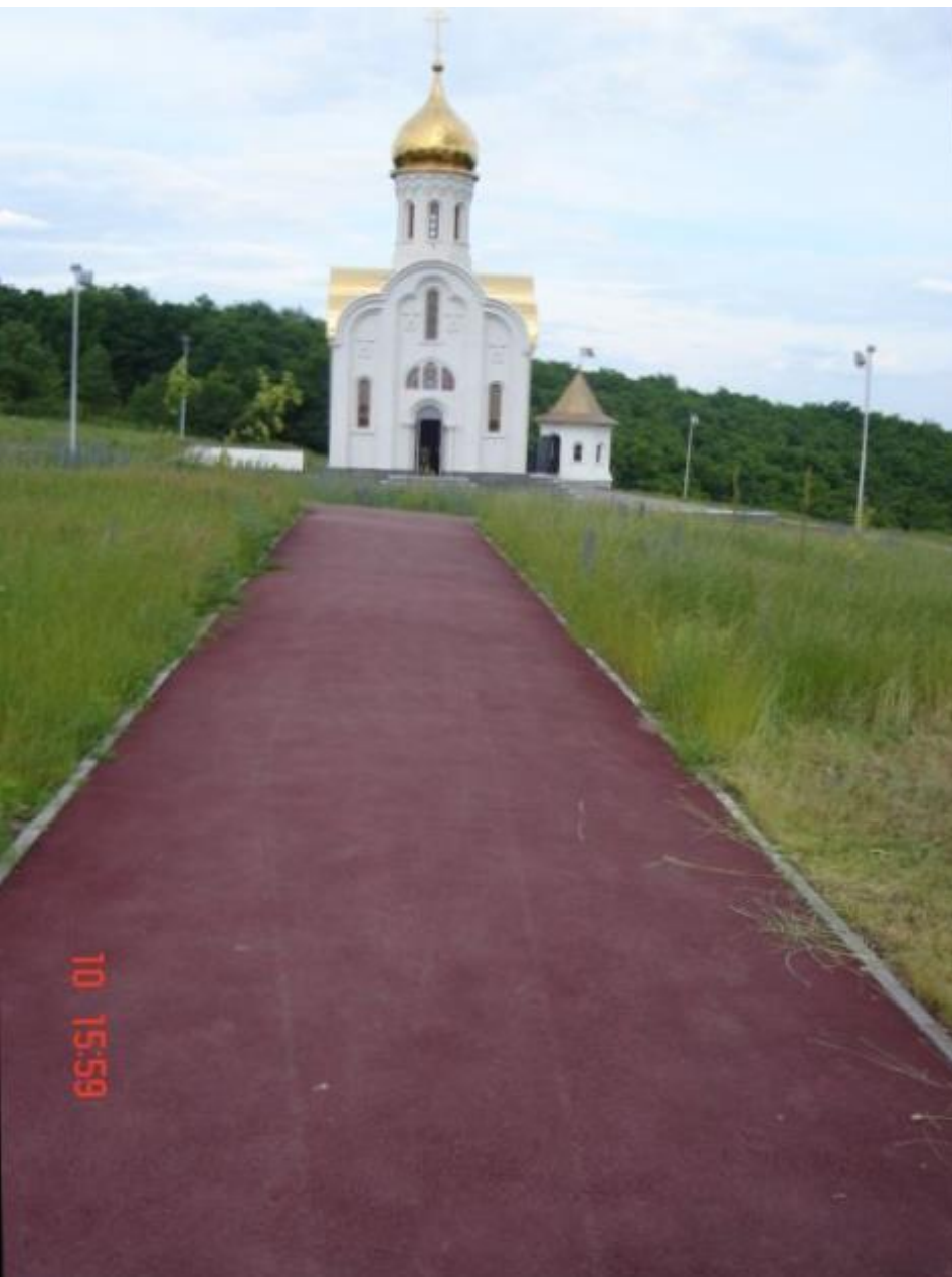
Покрытие из цветного асфальтобетона, устроенное у Национального мемориального комплекса «Высота маршала И.С.Конева»
