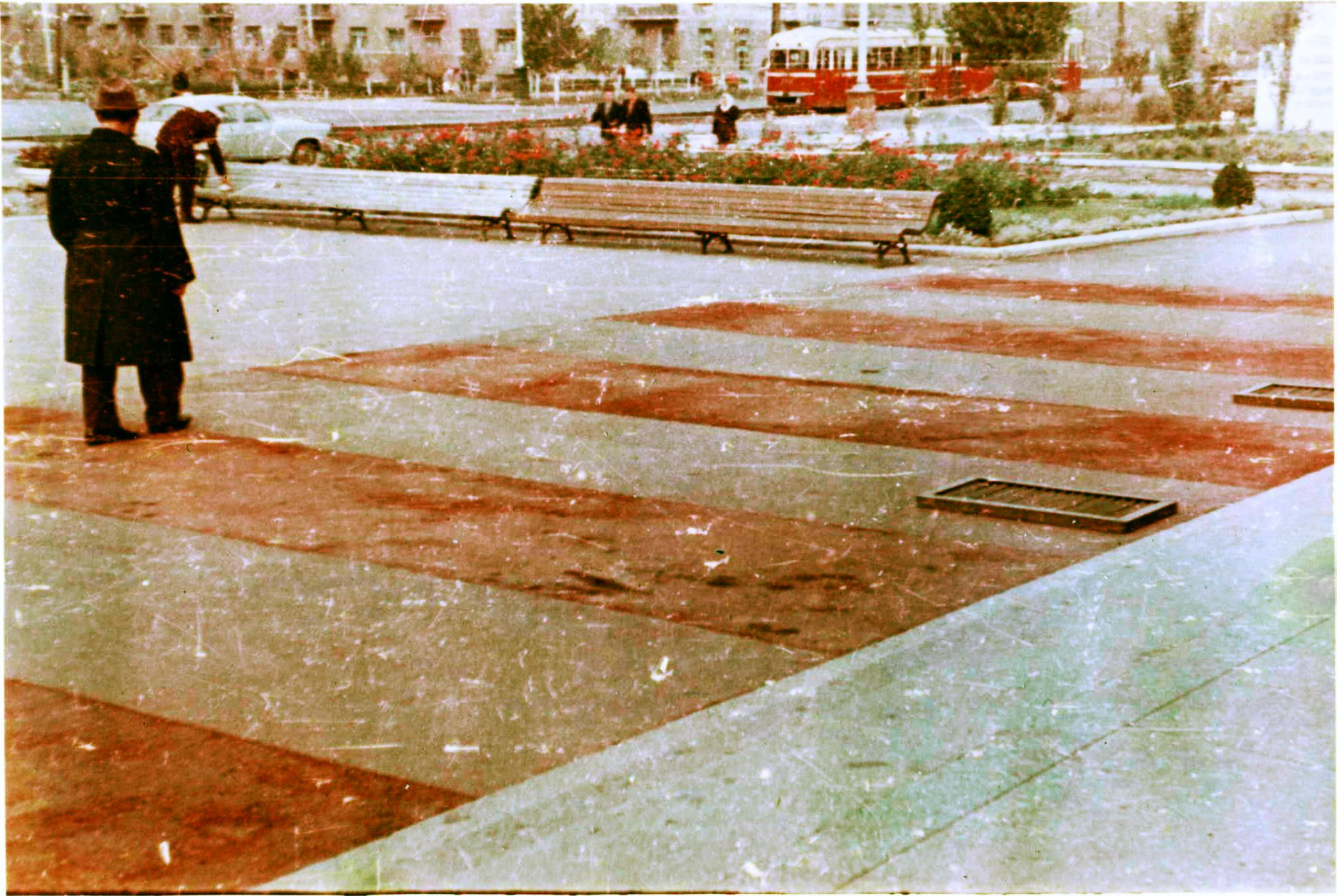
Пешеходный переход в г. Луганск (1961) из термопластбетона на основе кумароновой смолы - неудачный опыт
