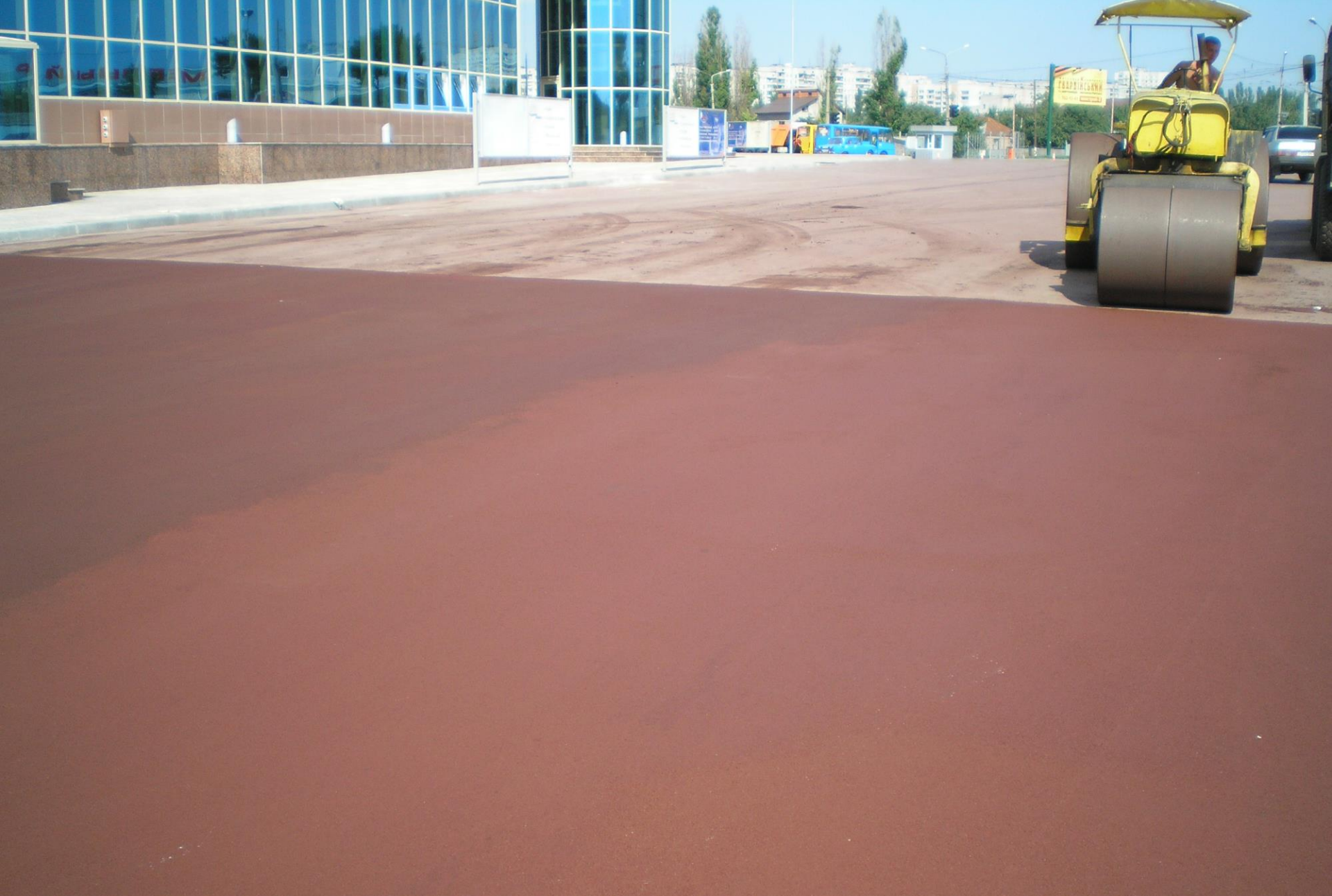
Покрытие из цветного асфальтобетона, устроенное возле презентационно-выставочного центра «Радмир - Экспохолл», г. Харьков
