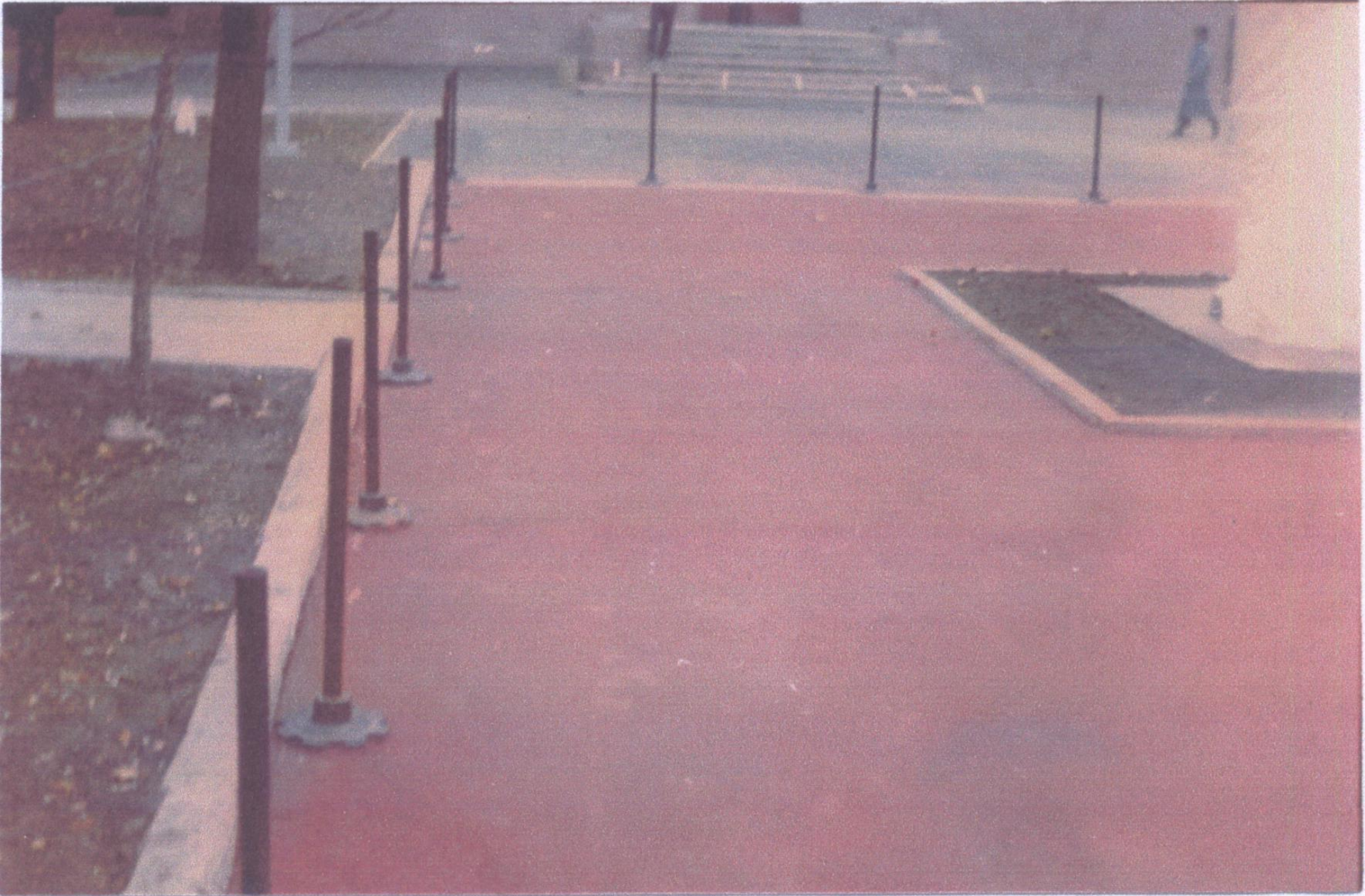
Площадка вокруг памятника В.И. Ленину из красного пекополимербетона в г.Барнауле (1990 г.)
