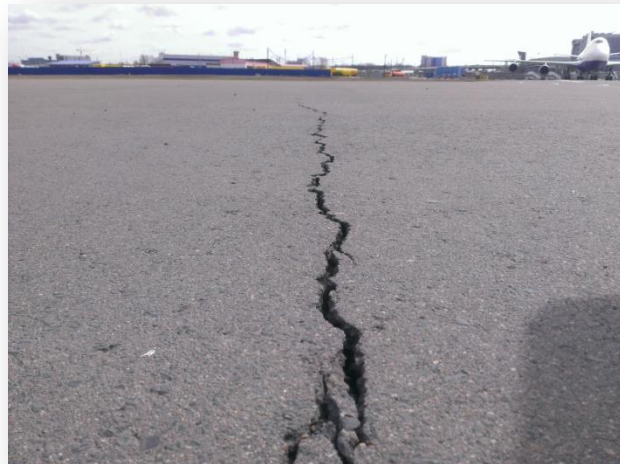
Трещины асфальтобетонного покрытия с большой шириной раскрытия
