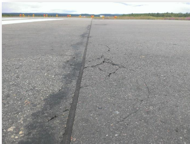
Эрозия от газовоздушных струй
