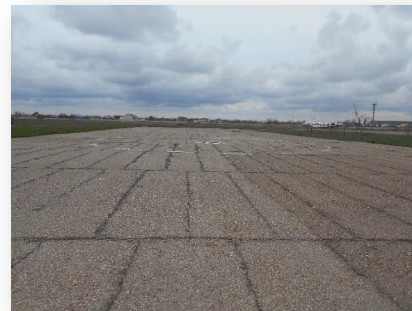
Отраженные трещины
