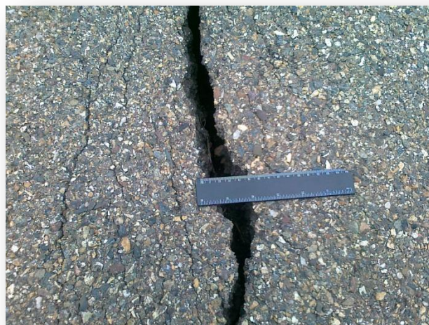
Трещины асфальтобетонного покрытия с большой шириной раскрытия
