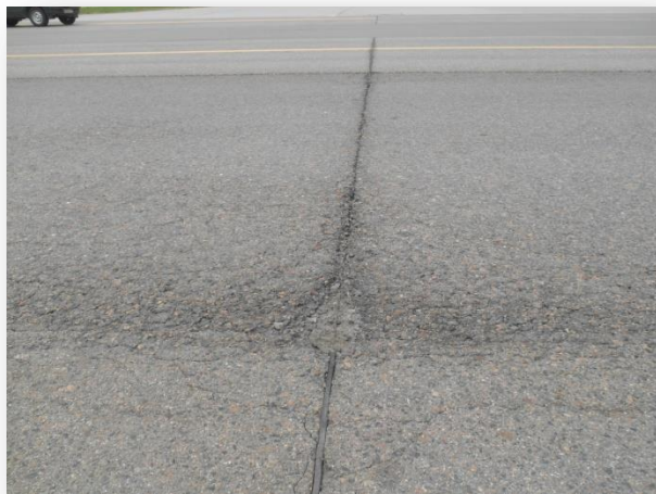
Эрозия от газовоздушных струй
