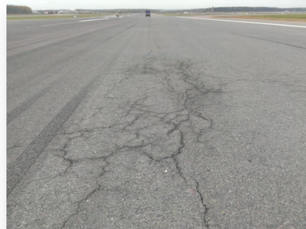
Частая сетка трещин
