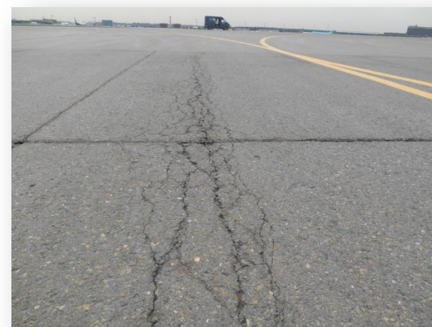
Отраженные трещины
