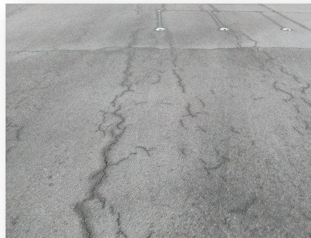
Частая сетка трещин
