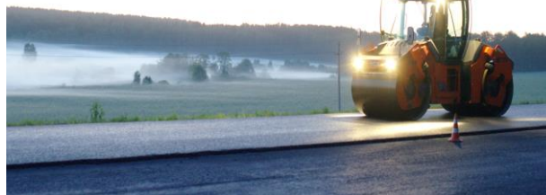
SuperPave 19, устройство верхнего слоя автомобильной дороги А-108
