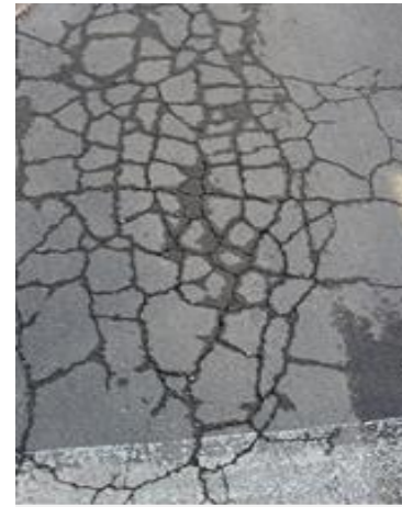
Усталостное трещинообразование
