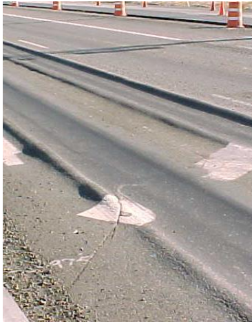
Остаточная и пластическая деформация
