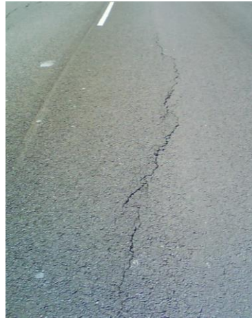
Низкотемпературное трещинообразование
