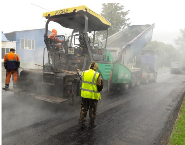
SuperPave 19, устройство верхнего слоя автомобильной дороги А-108
