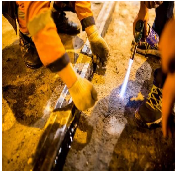
Устройство сопряжения асфальтобетонного покрытия с металлическими элементами деформационных швов на путепроводе с применением стыковочной ленты
