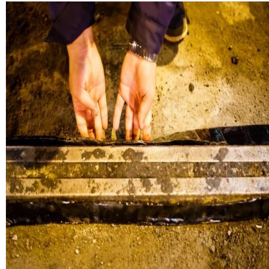
Устройство сопряжения асфальтобетонного покрытия с металлическими элементами деформационных швов на путепроводе с применением стыковочной ленты
