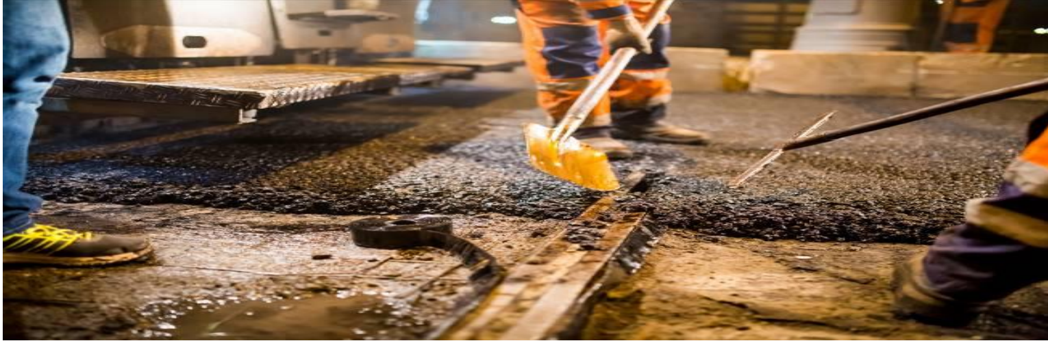
Устройство сопряжения асфальтобетонного покрытия с металлическими элементами деформационных швов на путепроводе с применением стыковочной ленты
