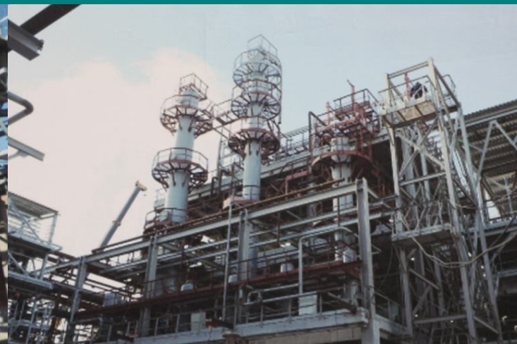
Январь 2013. Монтаж технологических трубопроводов
