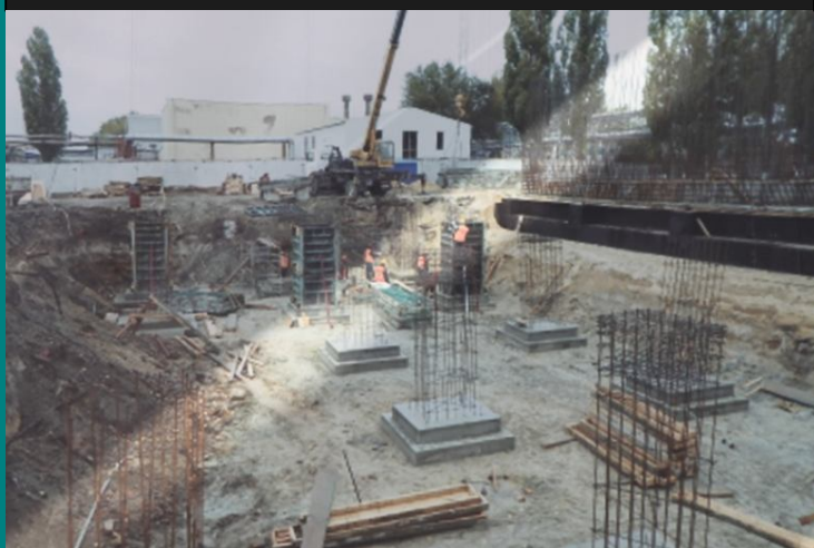
Август 2011. Разработка котлованов и заливка фундамента
