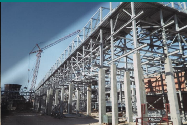
Август 2012. Строительство технологической эстакады
