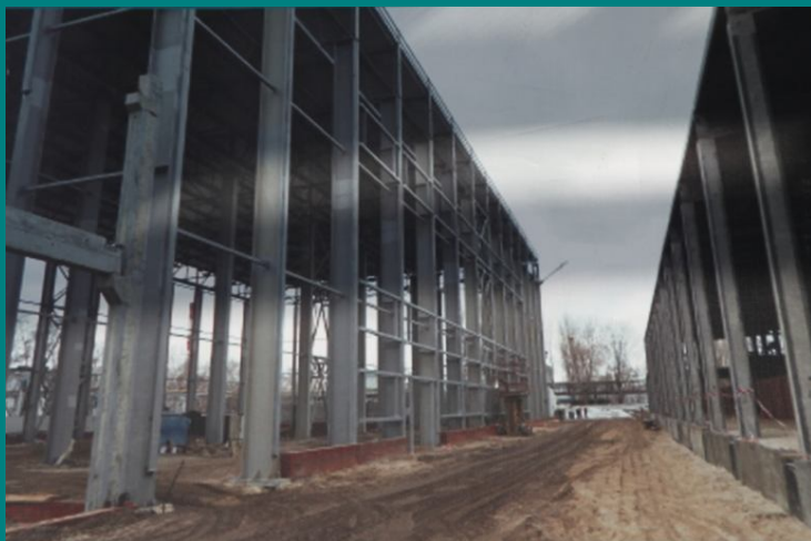
Декабрь 2011. Монтаж металлоконструкций зданий зоны А
