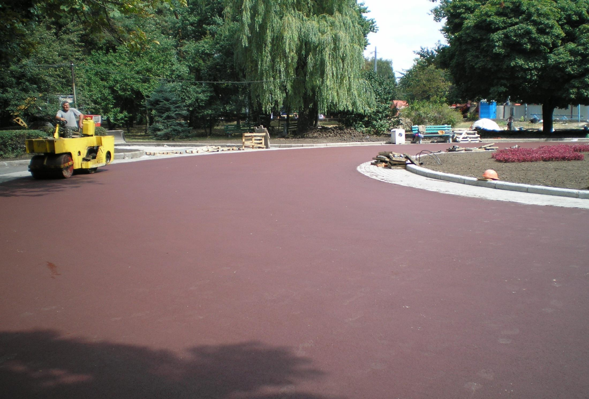
Покрытие из цветного асфальтобетона, устроенное в парке им. Горького г. Харьков (2006 г.)
