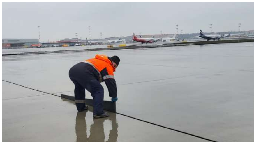
Разгерметизация швов расширения
