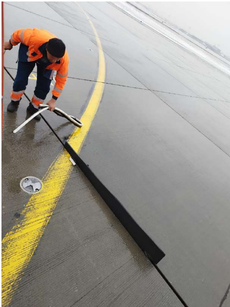
Разгерметизация швов расширения
